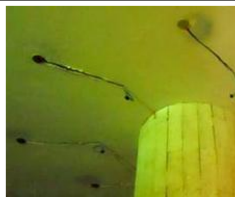
左官職人が仕事を終えた後、電気工事士がつけた溝が残る
